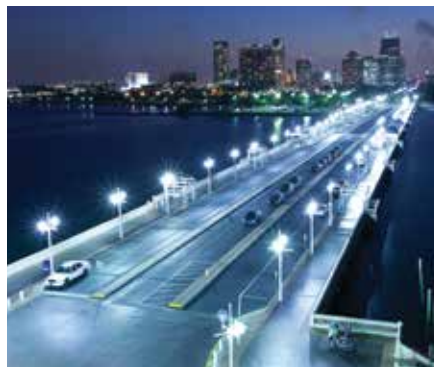
Cobrahead luminaires
